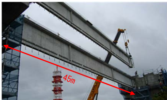
図-1 PCT 桁の架設状況
