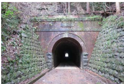
写真1 熊井隧道の坑門
