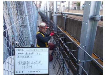
写真1 鉄筋組立状況
