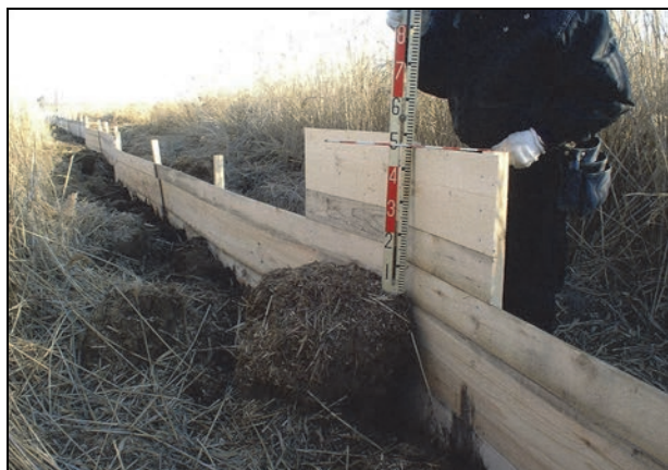
写真-2 侵入防止柵（木柵）設置状況
