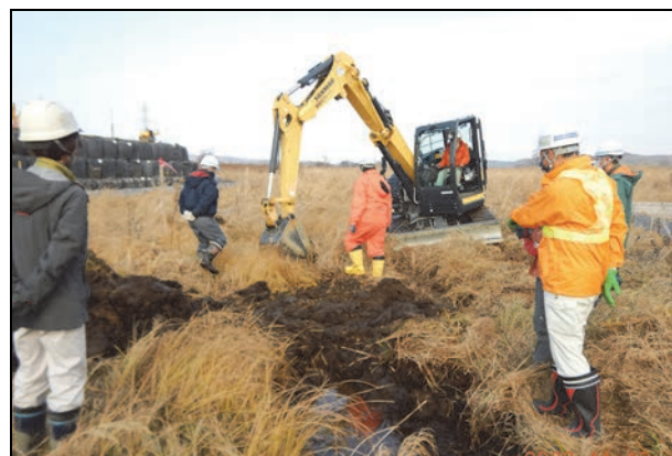
写真-3 産卵環境創出（掘削）状況
