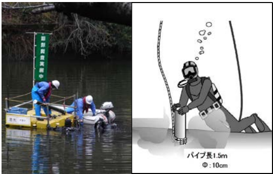
図－2 潜水作業による採泥状況
