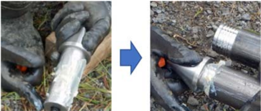
写真-1 着脱式コーンの鋼管への装着状況
