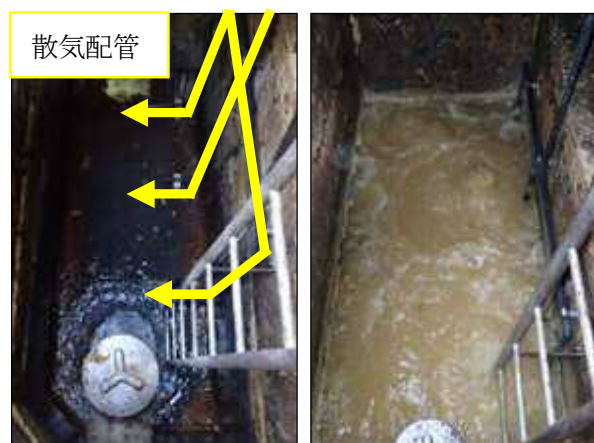
写真2. 散気配管設置と改善後の状況
