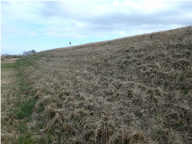
図－1 試験施工箇所（上流側より撮影）
