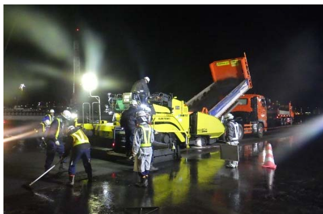
写真-2 空港の夜間舗装
