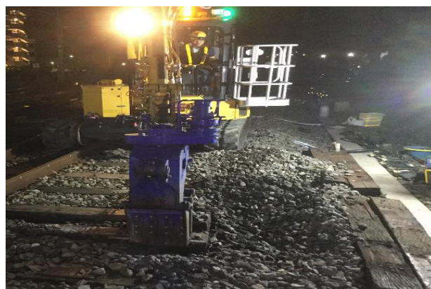
写真-3 破線法+マクラギグリッパー施工
