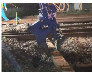
写真-1 マクラギグリッパー 写真-2 グラップリングバケット
