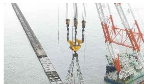
図 5 1 点吊フック使用状況
