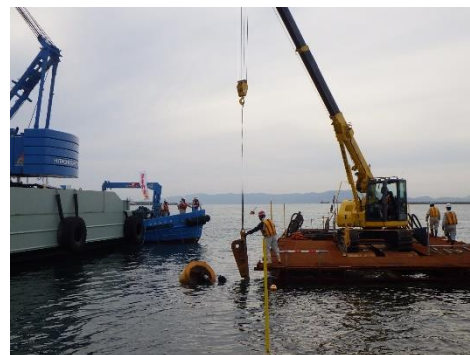
図 7 クローラークレーン設置状況
