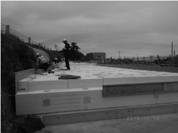
写真 1 EPS 工法施工状況
