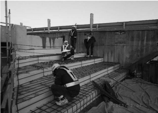
写真 2 床版配筋状況
