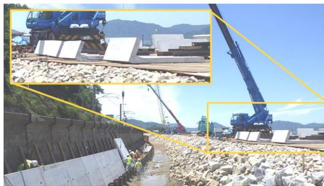
写真-4 プレキャストパネル据付状況
