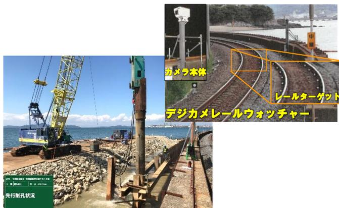
写真-3 鋼矢板工施工状況
