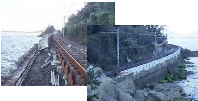
写真-2 被災状況・応急復旧完了
