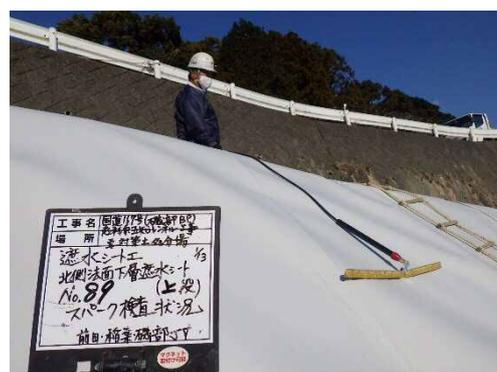
写真-3 法面部のスパーク検査
