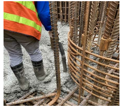
図-3 パイルキャップ打設状況
