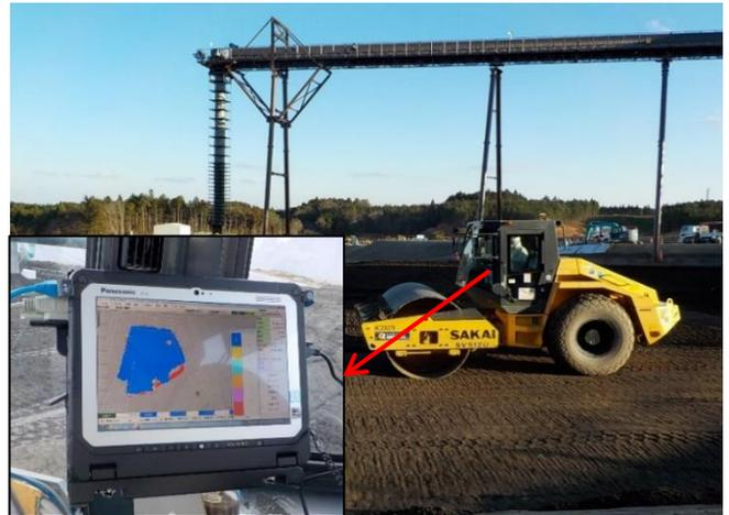
図-3 GNSSによる転圧管理
