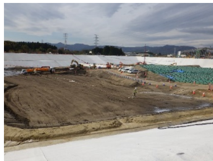
写真-4 飛散防止措置の実施状況
