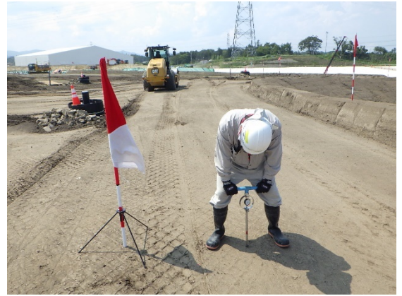
写真－5 コーン貫入試験状況
