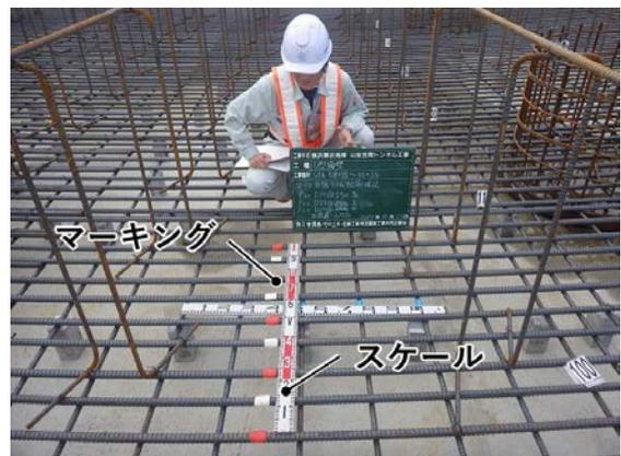
図-2 従来の配筋検査の立会写真
