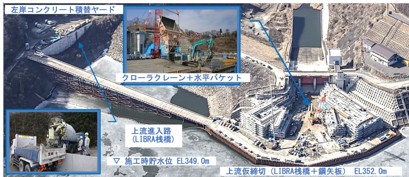
写真-2 コンクリート打設設備配置
