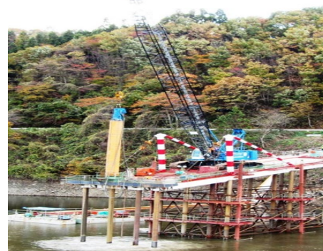
写真-1 LIBRA工法による栈橋架設
