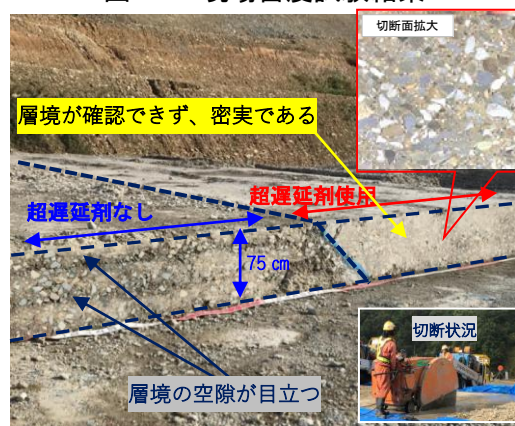
写真-2 CSG施工ヤード切断面
