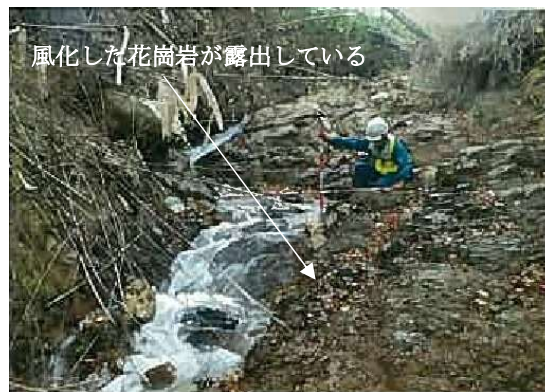
写真-2 B 沢上流部の状況
