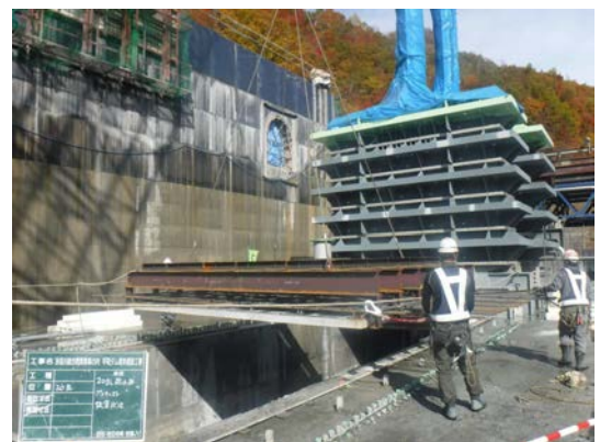
写真-2 常用洪水吐き天端スラブ
