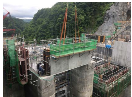
写真-3 上流断面変化梁部
