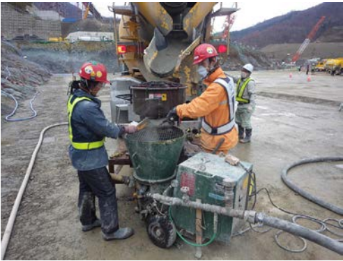
写真-5 モルタル吹付け機(斜面部)
