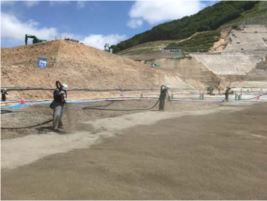
写真-4 モルタル吹付け状況(3 セット)
