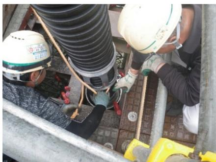
写真2 アンカー孔への挿入状況
