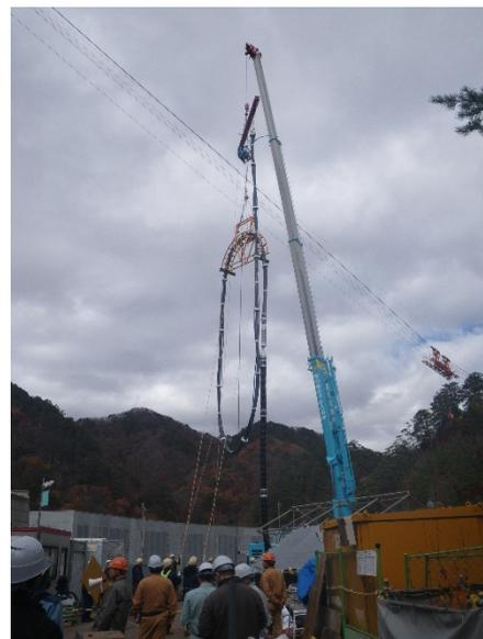
写真1 tendon 吊上げ状況
