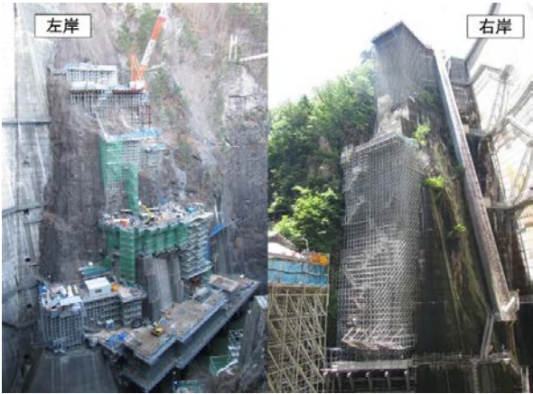
図 1 足場設置状況
