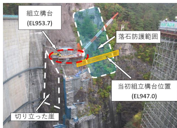
図4 タワークレーン組立構台
