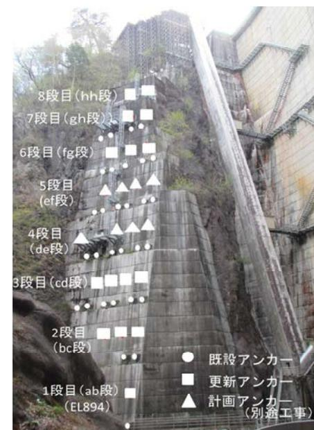
図-2 アンカー配置図（右岸C部）
