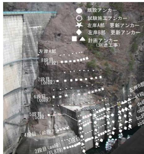
図-1 アンカー配置図（左岸A・B部）
