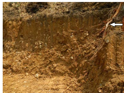
写真-2 コア細粒材の堆積状況 (試掘状況)
