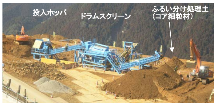
写真-1 コア細粒材の木根分別処理の実施状況
