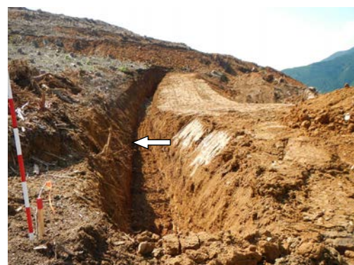
写真-1 コア細粒材の木根分別処理の実施状況
