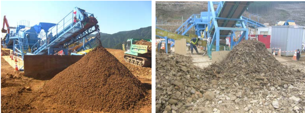
写真-3 分別処理後のコア細粒材（左）と木根混じり土（右）
