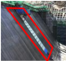
図-5 下流面養生蓋
