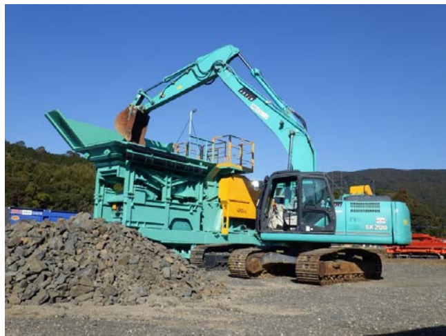
写真-3 実証試験（タグチ工業機）状況
