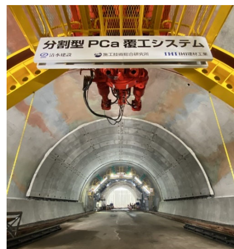
写真-6 組立完了状況
