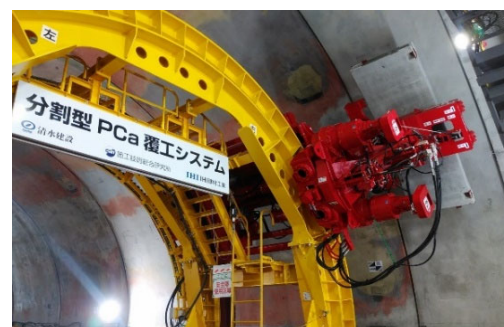
写真-4 PCa 覆工ピースの設置状況
