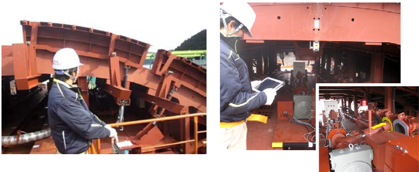
図-2 左：鋼製妻型枠 右：新型エレファント(自動配管切換装置)
