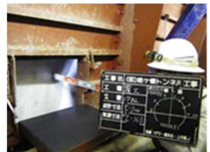
写真-2 出来形計測の状況
