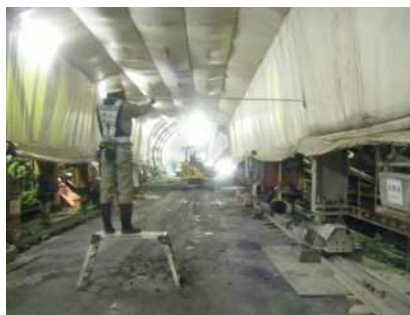
写真-1 据付け作業の状況
