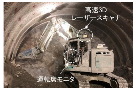
図-5 切羽掘削形状モニタリングシステムを用いたあたり取り
