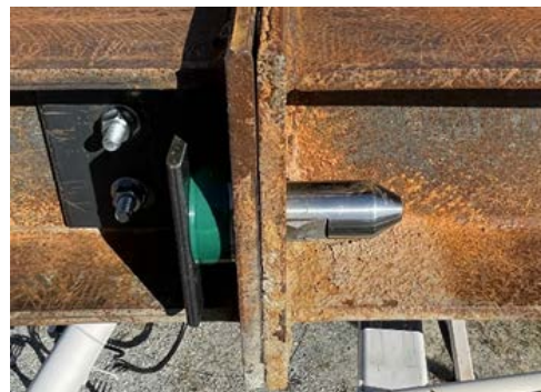
写真3 ワンタッチ式継手ボルトによる締結
