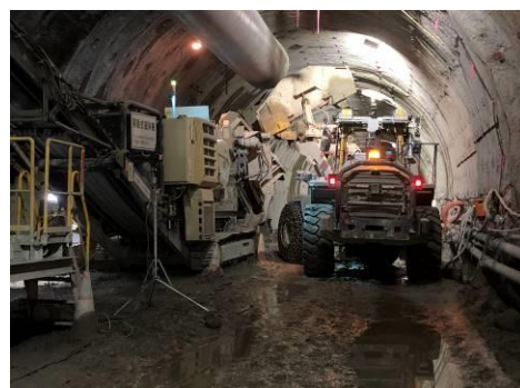
図－6 現場試行（遠隔運転）状況
