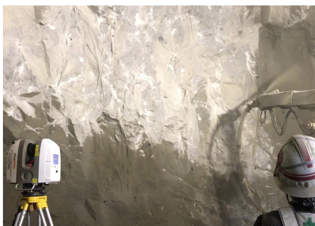
写真 1 レーザースキャナによる測定状況
