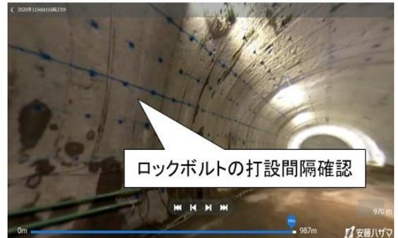
図-3 ロックボルト打設間隔の確認
