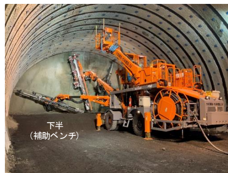
図-4 6m継ぎロックボルト施工状況
