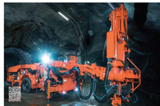
図-3 ロックボルト専用機（例）
