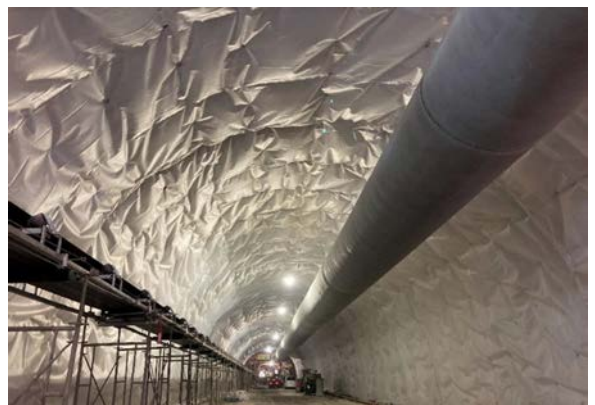
写真-1 張り付け完了全景
