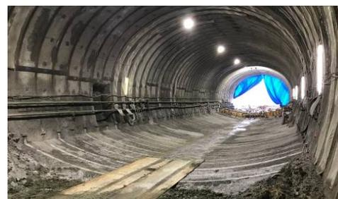
写真1:インバートストラット施工完了
