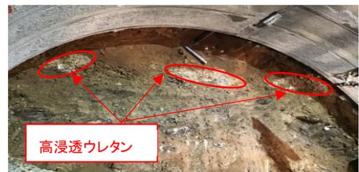
写真 2 補助工法施工状況
