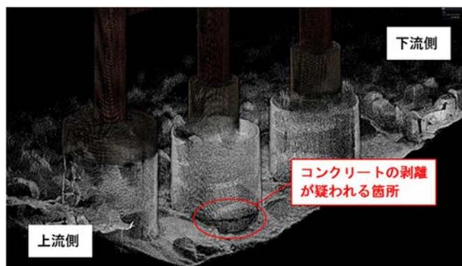
図-6 深浅測量の結果（点群データ）
