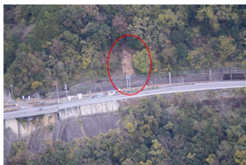
図-1 ヘリコプターによる斜面調査
