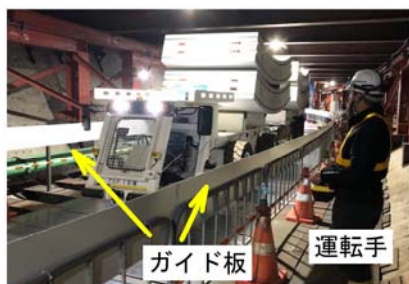
写真-3 遠隔操作による自動誘導運転
