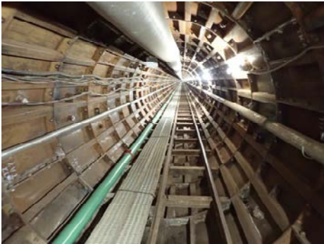
写真-1 長距離圧送状況
