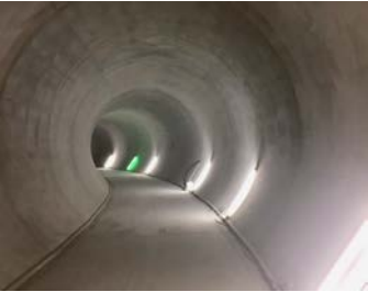
写真-5 構築した二次覆工
