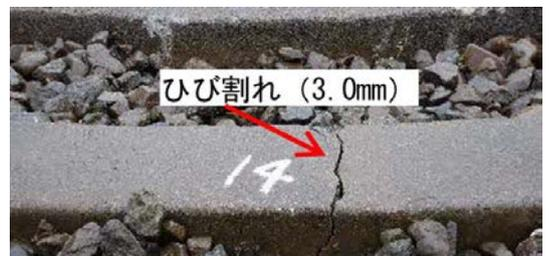
図-6 ひび割れ 3.0mm
