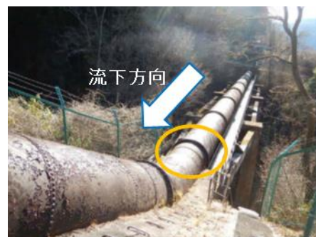
写真 2 逆サイフォン管外観
