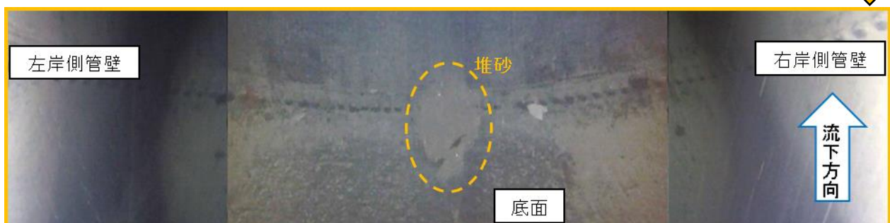
写真 3 浮体点検装置により撮影した逆サイフォン管内部（下面）の状況【通水中】
