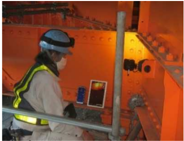
写真-2 鋼部材の中継の状況
